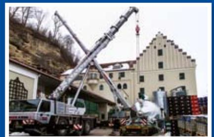
Heavy-Metal-Ballett: Mit schwerem Gerät werden die Edelstahltanks ins Brauereigebäude gehoben.
